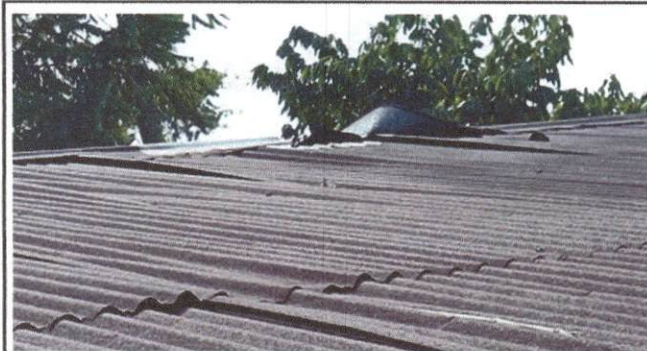
Foto 3: levantamiento de capota por los fuertes vientos y entra el agua durante el invierno.
